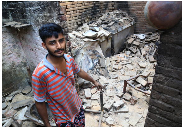
Nach der Mobgewalt in Jaranwala findet ein Christ sein Haus nur noch in Trümmern vor. Die extremistische Partei TLP hatte die Zerstörungswut mit ihren Parolen provoziert und viele ihrer Anhänger folgten dem Aufruf.
